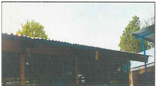
Foto 4 : Instalación de canales.
