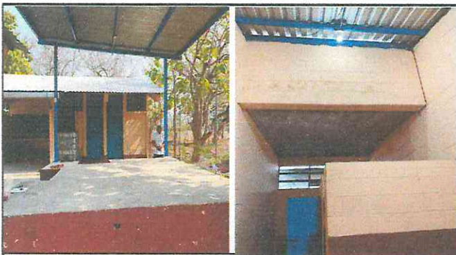
Foto 3: Instalación de pared para fondo de escenario y reparación de lamparas en los baños.
