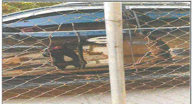
Foto2: sustitución de muro perimetral de Block y malla con tubo galvanizado
