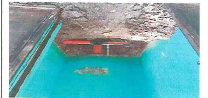
Foto 1: sustitución de tubería de tubería de PVC línea secundaria para aguas negras (posterior)
