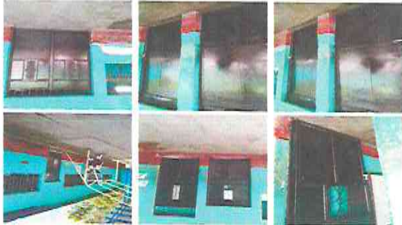
Foto 2: mantenimiento de puertas (lijado, pintura, tubo y vidrios)
