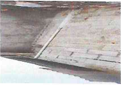
Foto 4: sustitución de tubería línea principal agua potable
