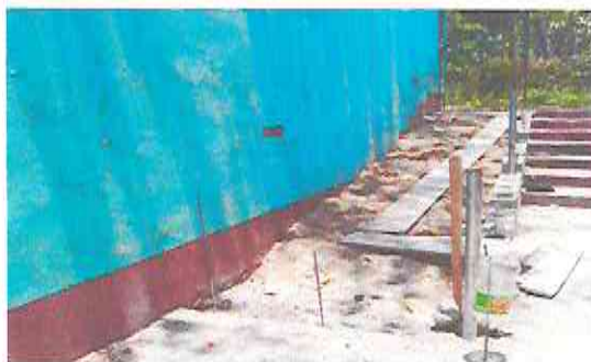
foto 3: sustitución de rampa para ingreso principal
