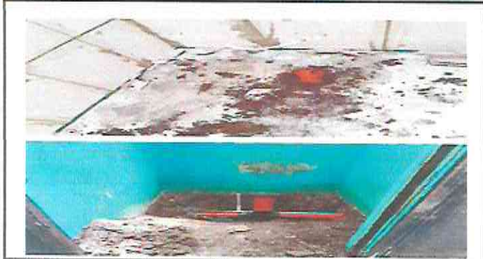
Foto 1: sustitución de tubería PVC línea secundaria para aguas negras
