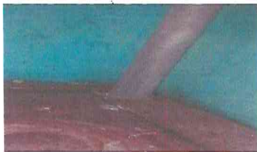
foto 1: sustitución de chimenea de concreto para estufa
