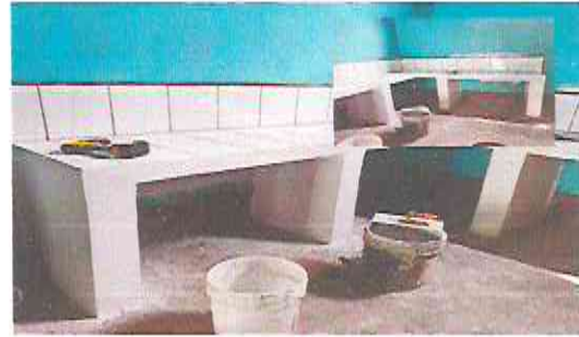
foto 2: Instalacion de azulejo en mueble de cocina.
