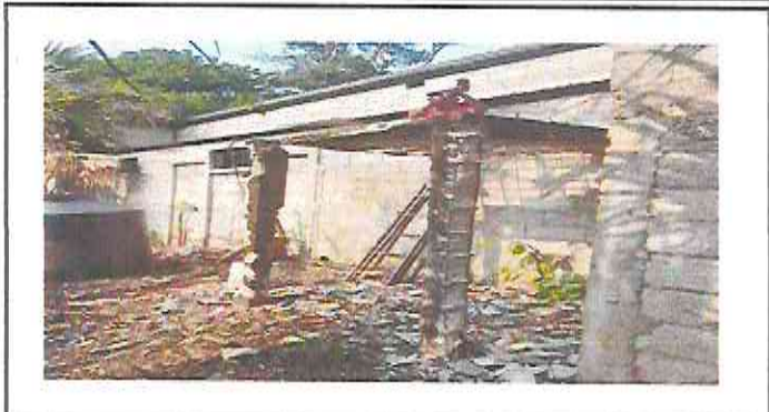
Foto 2: sustitución de estructura actual por estructura de mampostería para depósito de agua
