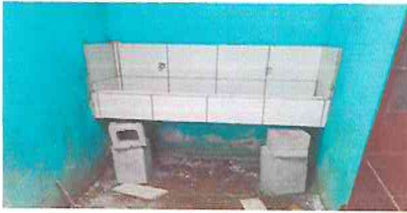
Foto 1: instalación de azulejos en mueble para lavamanos
