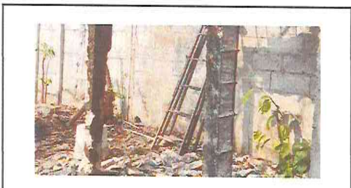
Foto 4: sustitución de tubería línea principal agua potable
