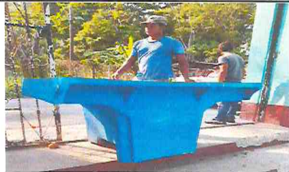
foto 6: Instalación de pila de cemento de de dos lavaderos
