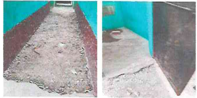
Foto 2: instalación de piso cerámico antideslizante
