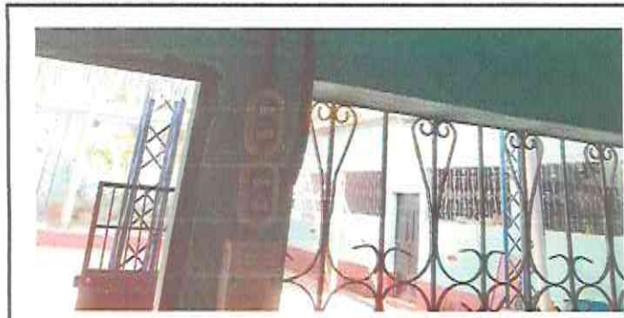
Foto 1: mantenimiento de balcón
