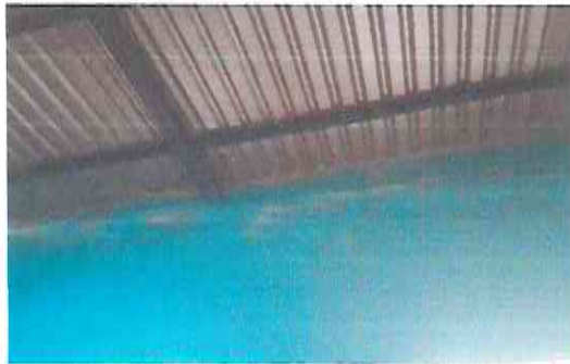
foto 3: cerramiento de paredes ) mojilnete
