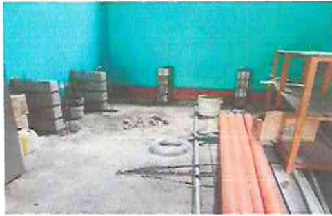
foto 1: instalación de mueble de cocina de concreto
