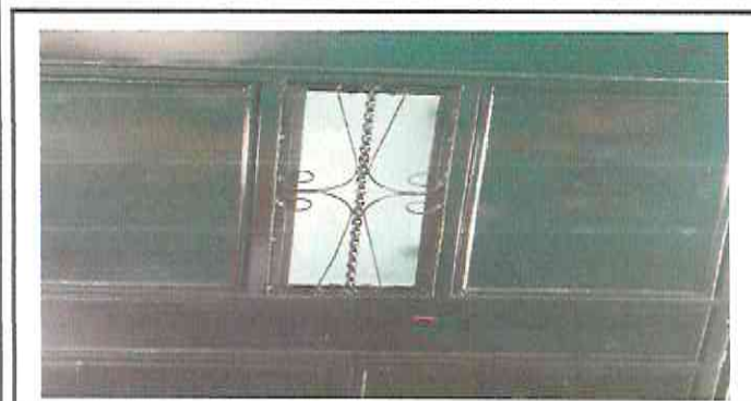
Foto 3: Instalación de puerta de metal
