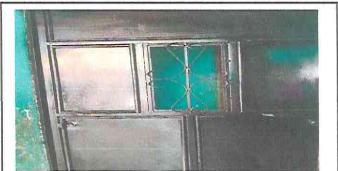
Foto 2: mantenimiento de puertas (lijado, pintura, tubo y vidrios)
