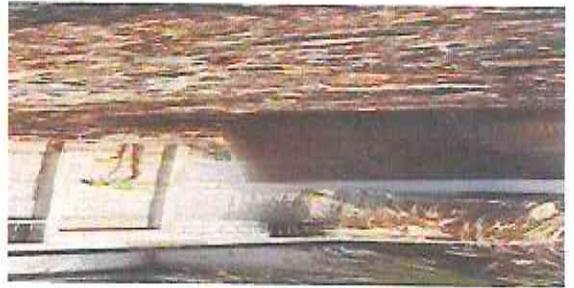
Foto 1: Sustitución de tubería de PVC línea secundaria para aguas negras.
