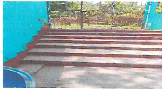
foto 2: sustitución de rampa para ingreso principal.
