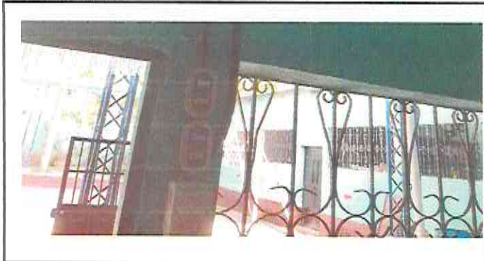
Foto 1: mantenimiento de balcón
