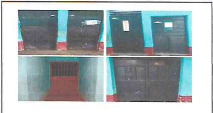
Foto 2: mantenimiento de puertas (lijado, pintura, tubo y vidrios)
