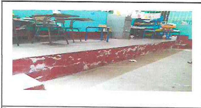
Foto 5: demolición de escenario
