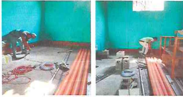
foto 1: instalación de mueble de cocina de concreto
