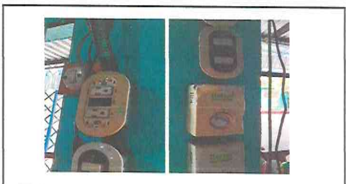
Foto 4: instalación de unidad de fuerza (ducto, tomacorriente, cableado y caja para verificadores)
