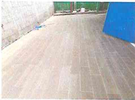
Foto 3.1. Sustitución o instalación de piso de torta de Concreto
