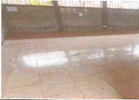
Foto 1.1. Sustitución o instalación de piso Cerámico
