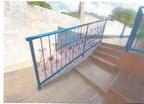
Foto 3.2. Ampliación de gradas de acceso
