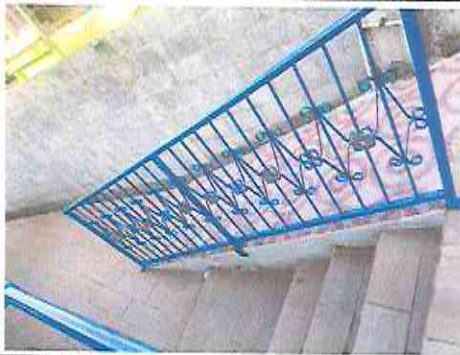
Foto 3.2 Ampliación de gradas de acceso
