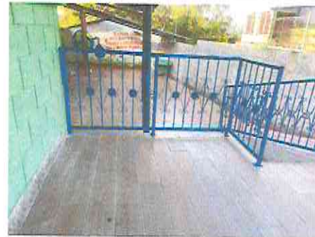
Foto 3.3. Suministro e instalación de baranda metalica en gradas
