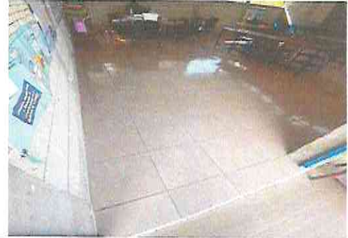
Foto 1.1. Sustitución o instalación de piso Ceramico
