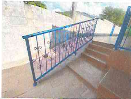
Foto 3.3. Suministro e instalación de barranda metalica en gradas
