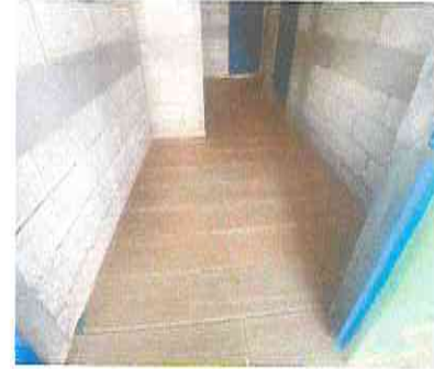
Foto 3.1. Sustitución o Instalacion de piso torta de concreto
