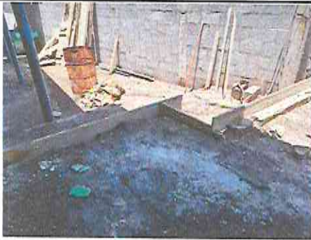
Foto 3.2. Ampliación de gradas de acceso
