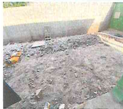
Foto 3.1. Sustitución o Instalacion de piso torta de concreto
