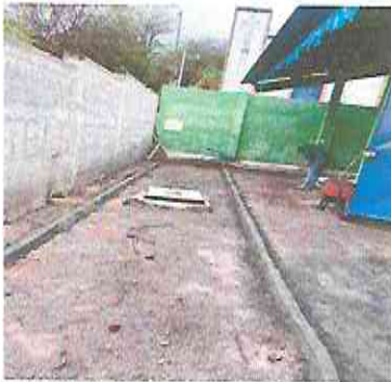
Foto 3.1 Sustitución o instalación de piso de torta de concreto.
