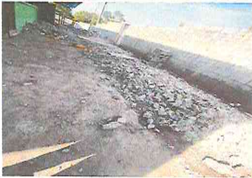
Foto 3.1. Sustitución o instalación de piso de torta de Concreto
