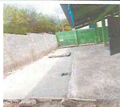
Foto 3.1 Sustitución o instalación de piso de torta de concreto.
