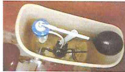
Foto 8: Sustitución de accesorios de inodoros existentes.
