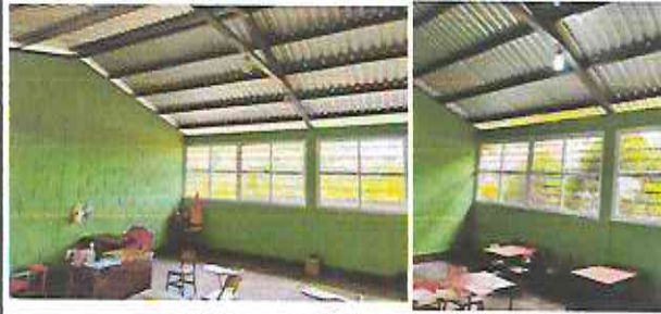
Foto 1: Instalacion de ventanas de PVC, Lamina toquelada cal.26, pintura en aulas.
