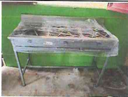
Foto 5: Sustitucion de estufa.
