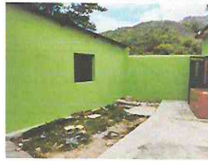
Foto 10: Aplicación de pintura en exterior de cocina y baños
