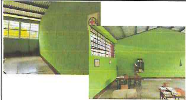
Foto 2: Instalacion de zocalo Ceramico y pintura en aulas.
