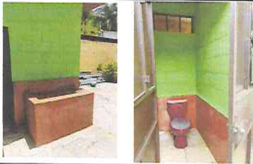
Foto 9: Instalación de azulejo en baños y pintura.
