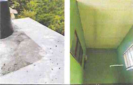
Foto 7: Impermeabilización de losa de concreto de baño y reparación de acabado en cielo de baños.
