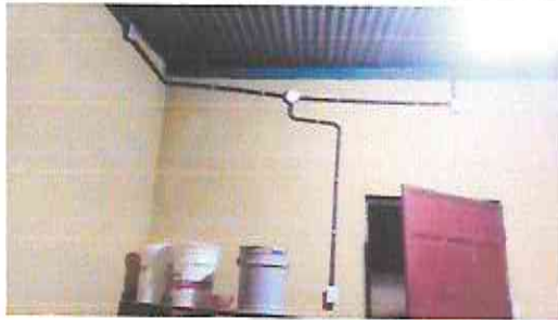
Foto 3: Instalacion electrica en cocina.
