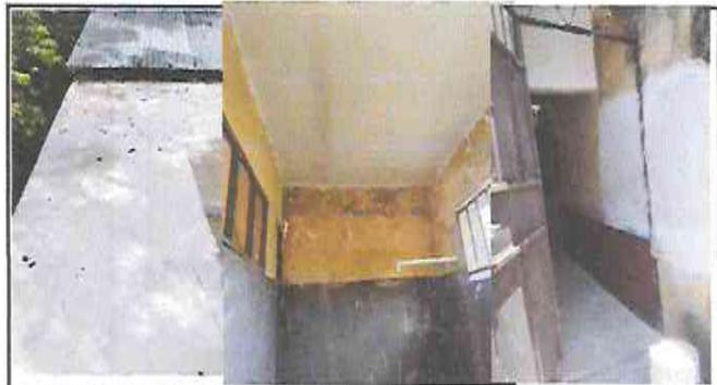
Foto 10: Aplicación de impermeabilizacion en losa de baños, reparacion de acabado en cielo y pared de baños.
