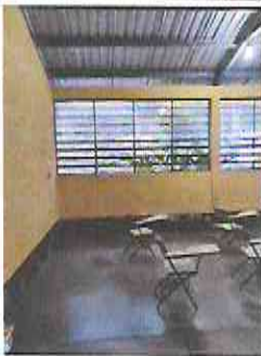
Foto 3: Cambio de ventaeria en mal estado por PVC y balcon metalico en aulas.
