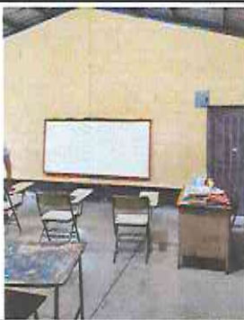
Foto 1: Instalacion de piso tipo ceramico, colocacion de zocalo y pintura general en aulas.
