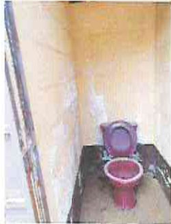
Foto 5: Cambio de artefactos en mal estado en area de baños, asi como colocacion de piso tipo ceramico, azulejo en pared y lavamanos de cemento y pintura general.
