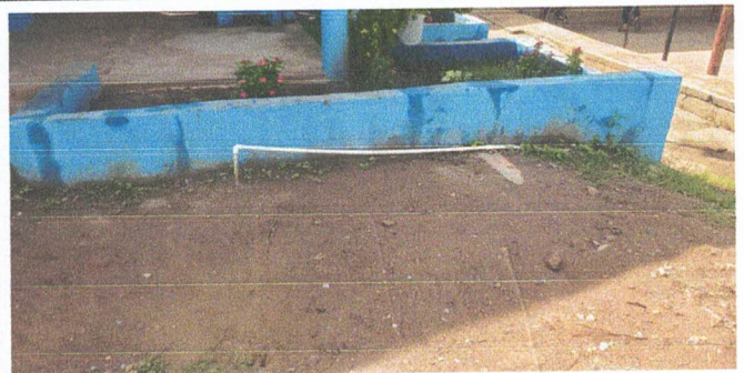
FOTO 6. SUSTITUCIÓN DE TUBERIA LINEAL PRINCIPAL
