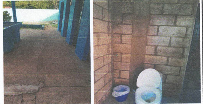
FOTO 4. SUMINISTRO E INSTALACION DE AZULEJO EN BAÑOS h=1.50m
