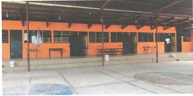
FOTO 1. MANTENIMIENTO CUBIERTA DE LAMINA DEL TECHO AULAS, DIRECCIÓN, BODEGA Y CORREDOR.
