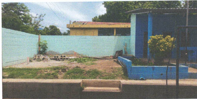
FOTO 5. MANTENIMIENTO DE REPOSADERA FOSA
