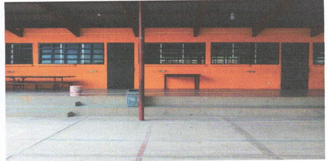
FOTO 2. MANTENIMIENTO A ESTRUCTURA DE LAS PUERTAS PARA NIVELACIÓN DE PISO (CORTAR)
