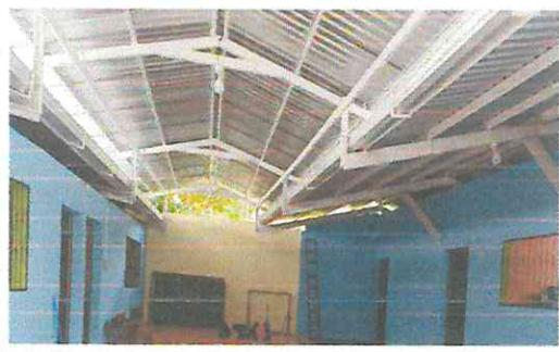
FOTOGRAFÍA No. 3 SUSTITUCIÓN DE LÁMINA
