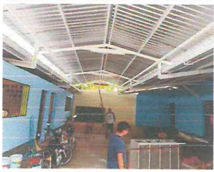
FOTOGRAFÍA No. 3 SUSTITUCIÓN DE LÁMINA
