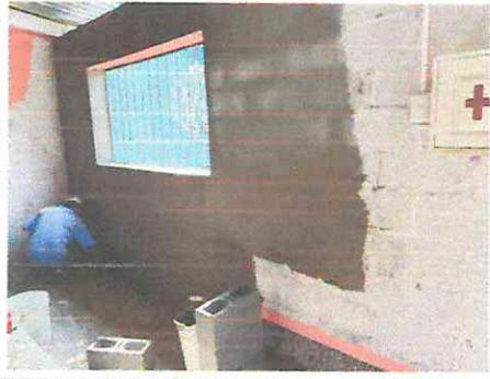
FOTOGRAFÍA No. 1 REPELLO Y SANITIZACIÓN EN MUROS
