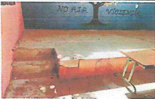
FOTOGRAFIA No.3 SUMINISTRO E INSTALACION DE PISO CERAMICO EN ESCENARIO ✓
