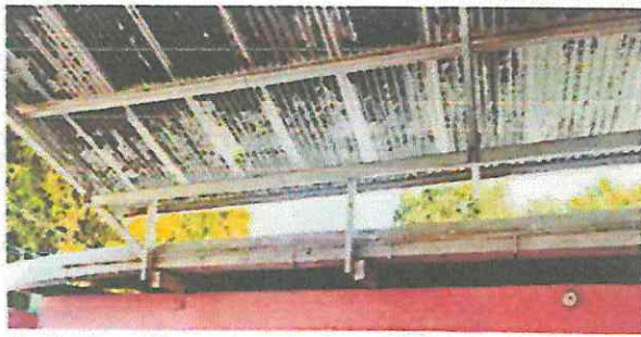
FOTOGRAFIA No. 5 SUSTITUCION LAMINA TROQUELADA ✓
