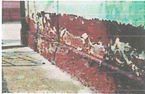
FOTOGRAFIA No. 1 REPELLO Y CERNIDO EN MUROS ✓
