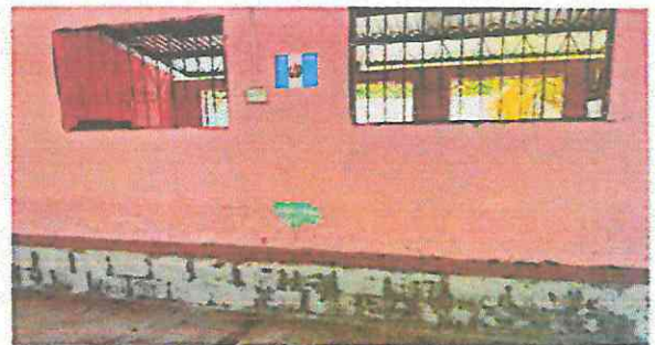
FOTOGRAFIA No.6 PINTURA EN MUROS ✓
