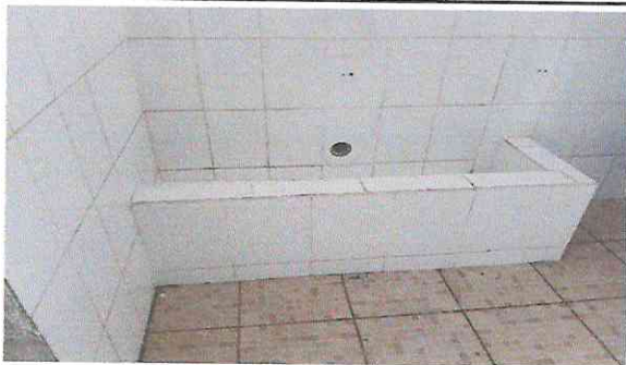
Foto 9: Sustitución de mingitorio.
