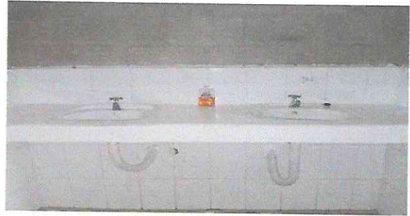
Foto 8: Sustitución de lavamanos.
