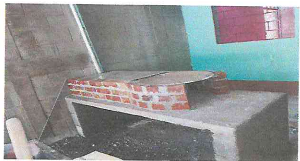
Foto 10: Sustitución de estufa rural.
