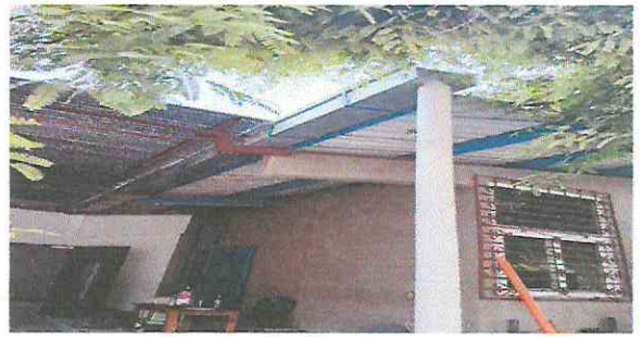
Foto 6: Canales y bajadas de agua pluvial.
