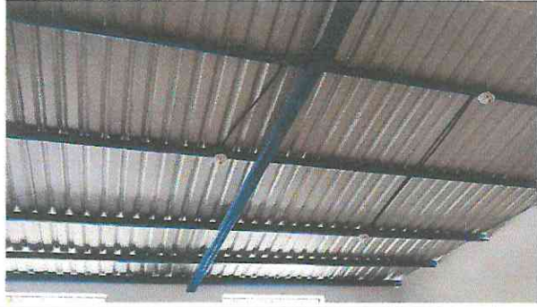
Foto 1: Cambio de techo y reparación de estructura metálica.
