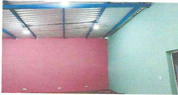
Foto 7: pintura en muros exteriores e interiores.
