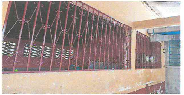
Foto 4: Mantenimiento a estructura de metal a ventanas.
