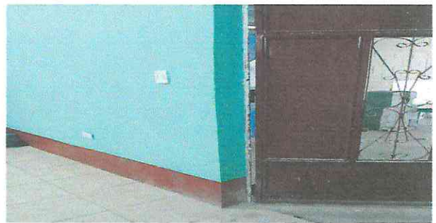
Foto 2: Mantenimiento de puertas.
