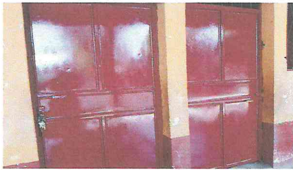
Foto 3: Sustitución de chapas.
