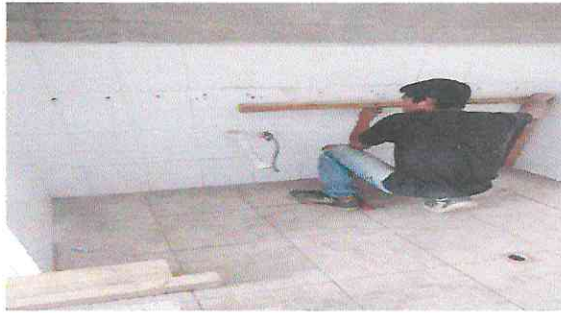
Foto 9: Sustitución de mingitorio.
