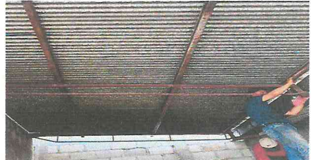
Foto 6: Canales y bajadas de agua pluvial.
