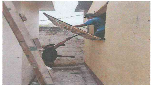
Foto 4: Mantenimiento a estructura de metal a ventanas.
