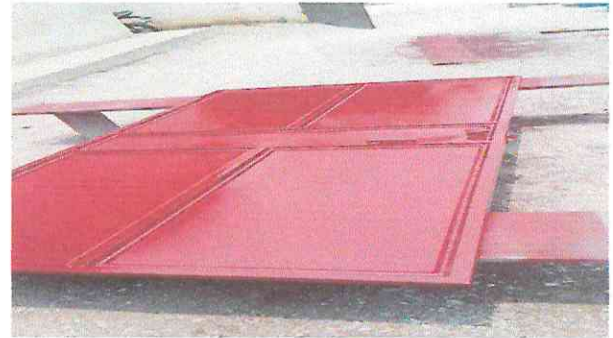
Foto 2: Mantenimiento de puertas.
