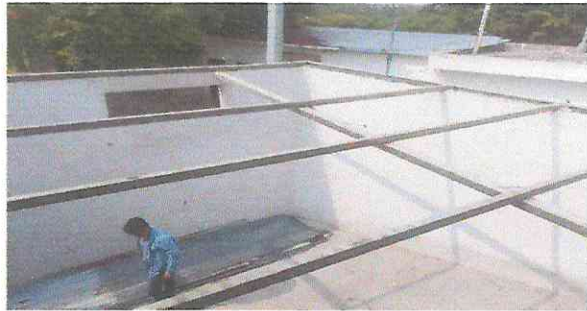
Foto 1: Cambio de techo y reparación de estructura metálica.
