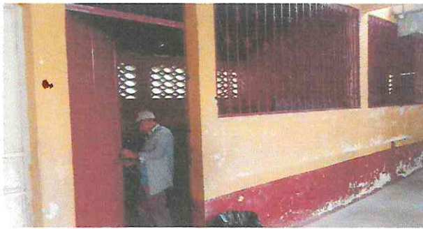
Foto 3: Sustitución de chapas.
