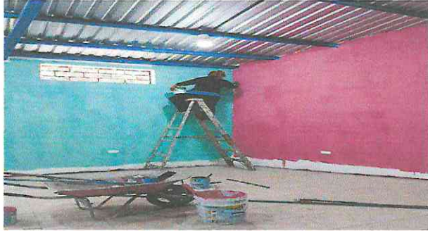
Foto 7: pintura en muros exteriores e interiores.
