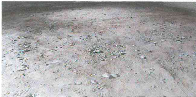
FOTO 5: Reparación de piso de torta de concreto, sustitución de piso de cerámico.
