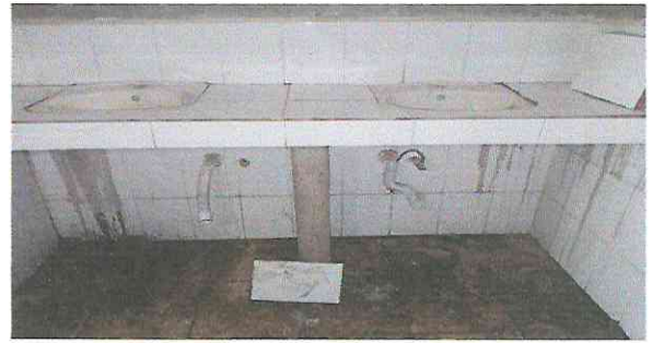
Foto 8: Sustitución de lavamanos.
