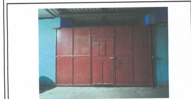
Foto 9: Mantenimiento a portón de metal
