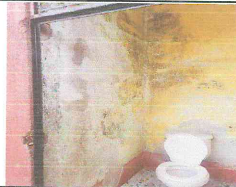
FOTO 4: Pintura en paredes exterior e interior de los sanitarios
