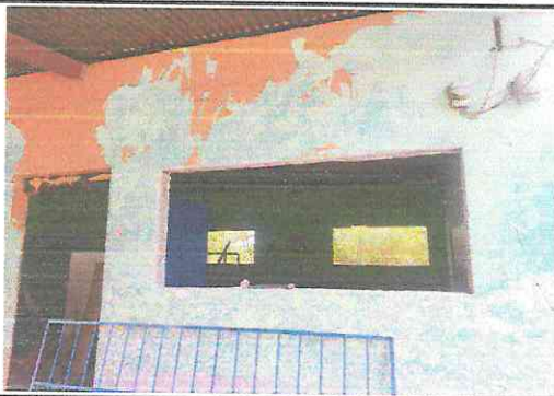
FOTO 5: Sustitución de balcones de metal
