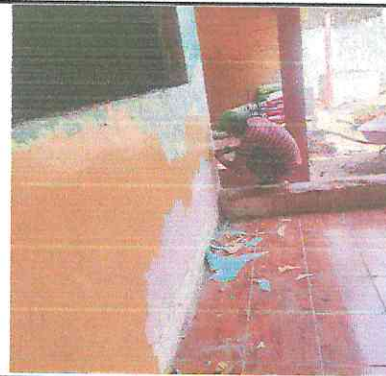
FOTO 2: Cernido de Paredes
