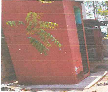
FOTO 1: Mantenimiento a puerta de metal y colocación de malla sobre el entel.
