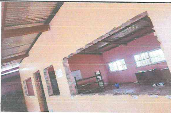
FOTO 3: SUSTITUCIÓN DE VENTANAS DE PVC
