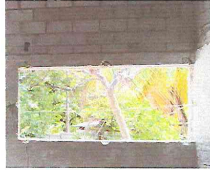
Foto2. Mantenimiento a estructura de metal de ventana y fabricación e instalación de ventana PVC en aula 1
