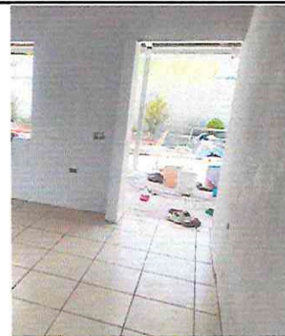
foto 8. Mantenimiento de estructura de metal de puerta aula 2
