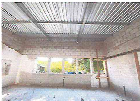
foto 11. Sustitución de lámina por lámina troquelada aluzin calibre 26, sustitución de estructura de soporte de madera por metal, levantado de muro con block para elevar el techo de lámina
