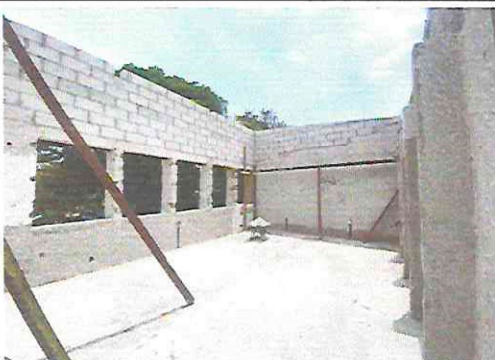
foto 9. Repello, cernido y pintura en muro interno aula 2
