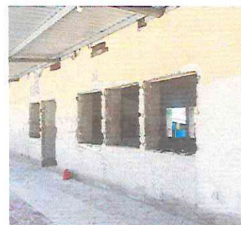
foto 10. Repello, cernido y pintura en muro exterior aula 2
