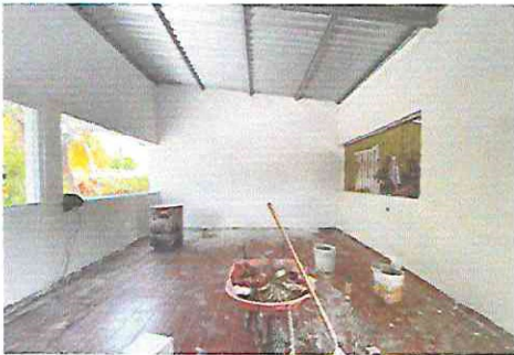
foto 3. Repello y cernido en muro interno y pintura en aula 1
