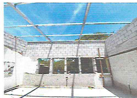
foto 12. Sustitución de ventana de madera por metal aula 2
