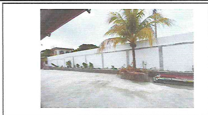
foto 14. Repello, cernido y pintura en muro perimetral lado interno
