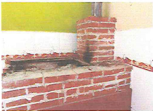
foto 7. Mantenimiento de estufa rural
