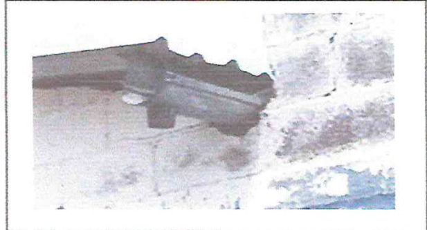
Foto 16. Reparación de bajada de agua pluvial
