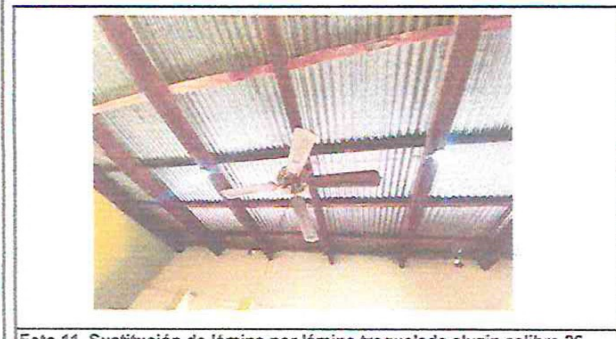
Foto 11. Sustitución de lámina por lámina troquelada aluzin calibre 26, sustitución de estructura de soporte de madera por metal, levantado de muro con block para elevar el techo de lámina
