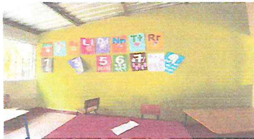
Foto 3. Repello y cernido en muro interno y pintura en aula 1
