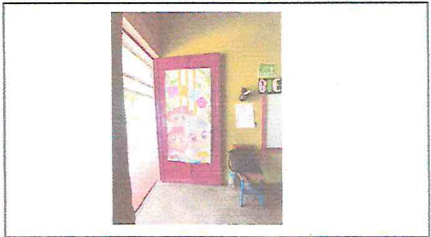
Foto 8. Mantenimiento de estructura de metal de puerta aula 2
