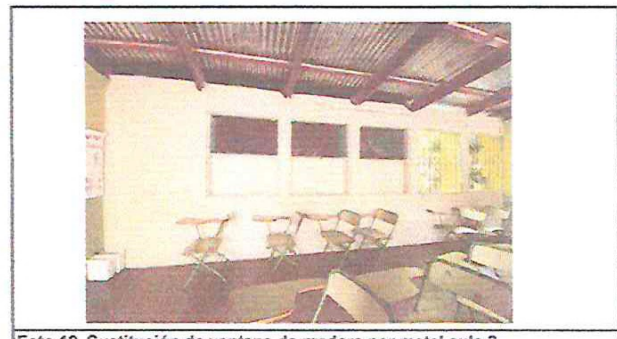
Foto 12. Sustitución de ventana de madera por metal aula 2
