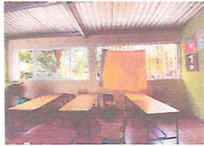
Foto 6. Levantado de muro con block para elevar el techo de lamina aula 1
