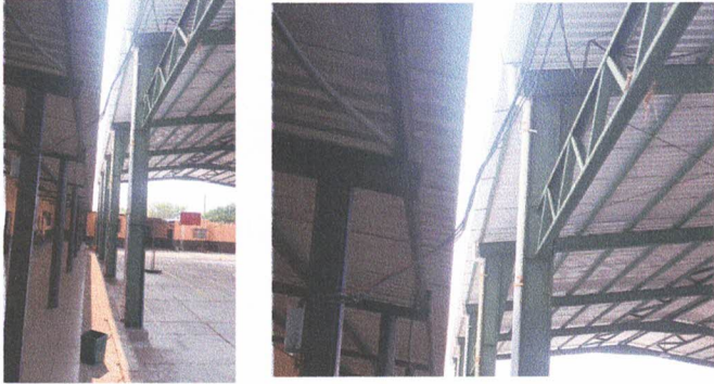
Foto 1: Sustrucción de tubería de aguas pluviales en área exterior, Colocación de canal para dirigir el agua pluvial del área de aulas y muy importante colocar una caja de captación para aguas pluviales.
