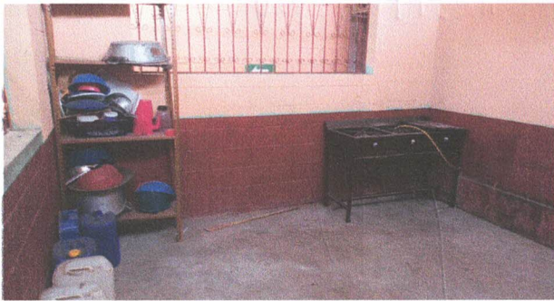
Foto 5: Construcción de mueble de concreto para cocina y forro de azulejo en top y división.
