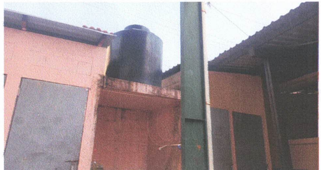
Foto 6: Losa que presenta humedad y fugas de agua, se deberá realizar un mezción para mantenimiento del área.
