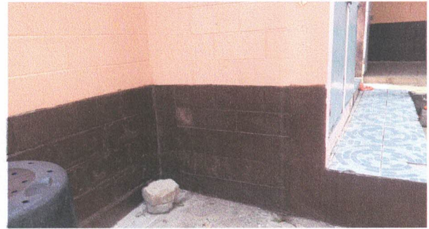
Foto 4: Area para colocación de lavamanos de concreto y forrado de azulejo
