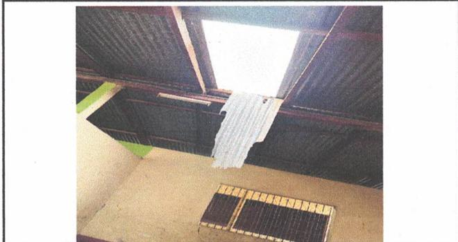
FOTOGRAFIA: SUSTITUCION DE LAMINA, POR LAMINA TROQUELADA CALIBRE 26, SUSTITUCION DE ESTRUCTURA DE SOPORTE DE MADERA, POR METAL EN MODULO DE COMPUTACION
