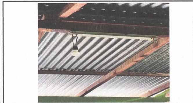
FOTOGRAFIA: SUSTITUCION DE LAMINA, POR LAMINA TROQUELADA CALIBRE 26, SUSTITUCION DE ESTRUCTURA DE SOPORTE DE MADERA, POR METAL EN, SUSTITUCION DE SISTEMA ELECTRICO EN MODULO
