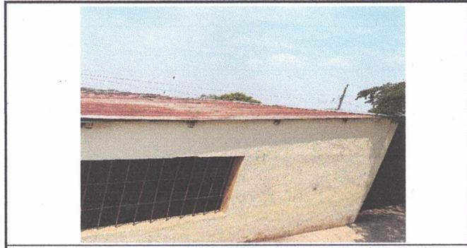
FOTOGRAFIA: SUSTITUCION DE LAMINA, POR LAMINA TROQUELADA CALIBRE 26, SUSTITUCION DE ESTRUCTURA DE SOPORTE DE MADERA, POR METAL EN MODULO DE SALON DE MAESTROS
