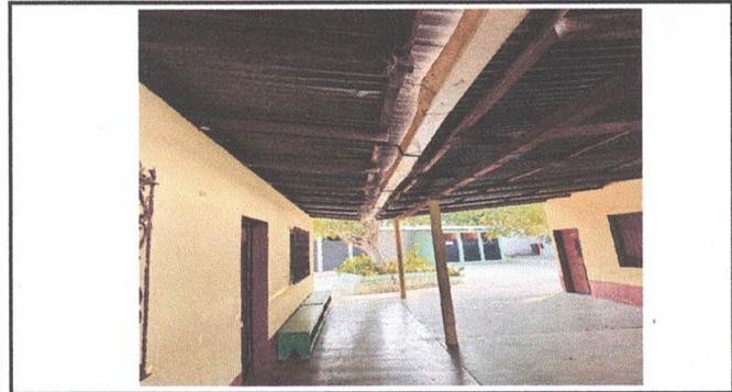
FOTOGRAFIA: SUSTITUCION DE LAMINA, POR LAMINA TROQUELADA CALIBRE 26, SUSTITUCION DE ESTRUCTURA DE SOPORTE DE MADERA, POR METAL EN MODULO DE COMPUTACION Y SALON DE MAESTROS.
