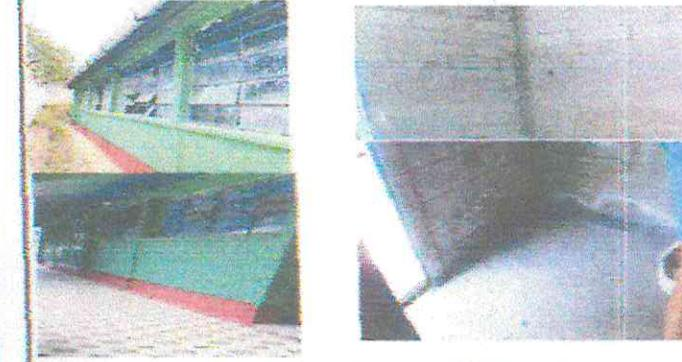
En esta parte quitaremos los vidrios, colocaremos ventanas pvc. Y lo que es tructura de metal lo convertiremos en balcones, se les dara mantenimiento de pintura, tambien se pintaran las paredes tanto interno
