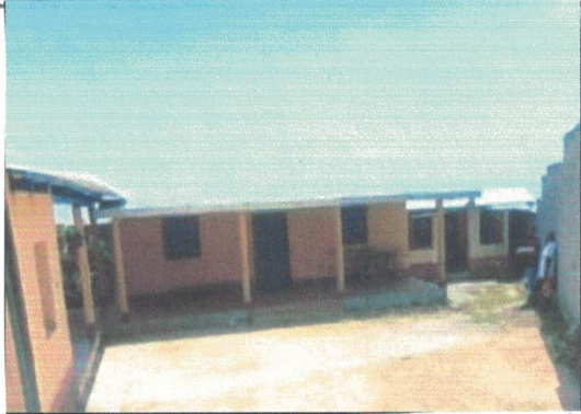
Foto1: Fabricación e instalación de galera con lamina Troquelada.
