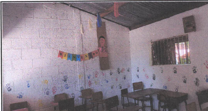
Foto 3: Pintura en muros interiores y exteriores, en muros de block rústico.
