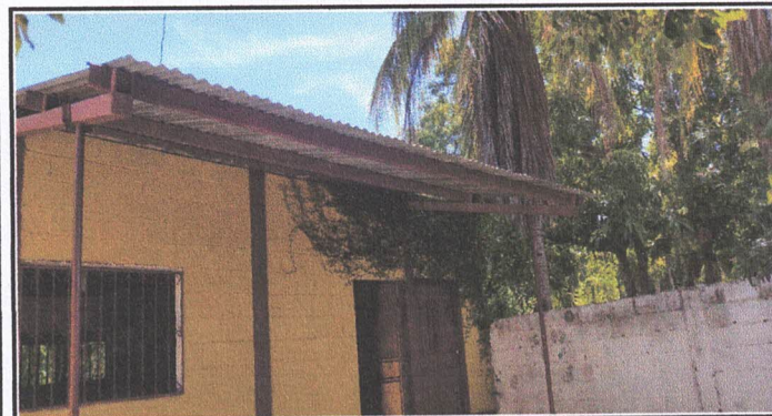
Foto 9: Instalación de canal para agua pluvial e instalación de tubo PVC y sus accesorios para bajada de agua pluvial.
