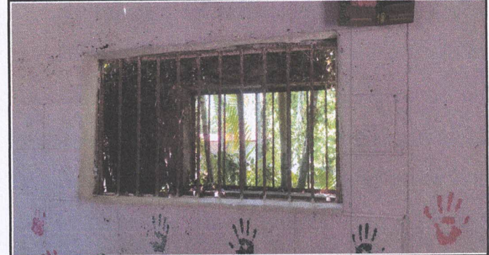
Foto 4: Mantenimiento en balcones de metal y colocación de ventanas de PVC.
