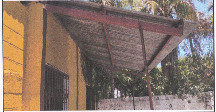
Foto 2: Mantenimiento (pintura) en estructura metálica de techo.
