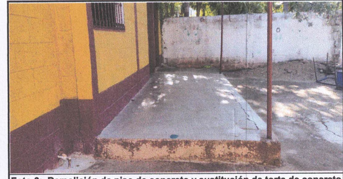
Foto 6: Demolición de piso de concreto y sustrucción de torta de concreto en corredor de aula e instalación de piso cerámico.
