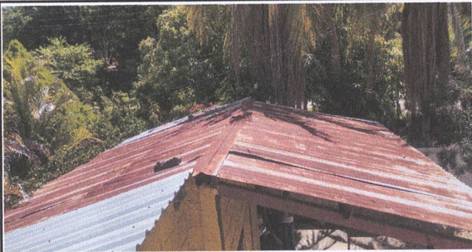
Foto 1: Módulo Aula. Sustrucción de lámina por lámina troquelada cal. 26.
