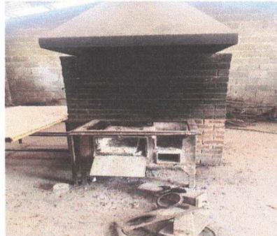
FOTOGRAFIA: SUSTITUCION DE ESTUFA RURAL (COMPLETA) INCLUYE CHIMENEA Y PLANCHA DE METAL EN MODULO DE COCINA
