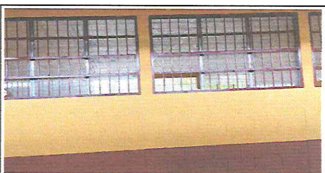
Foto 6: Pintado de aulas y balcones.
