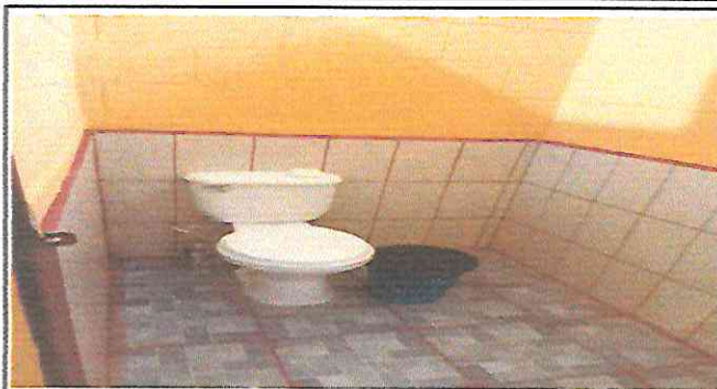
Foto 1: Instalacion de servicio sanitarios y pintado.
