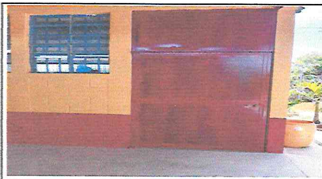
Foto 3: Pintado de puertas en aulas.
