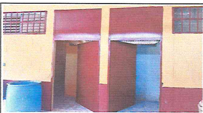
Foto 4: pintado de balcones en baños.
