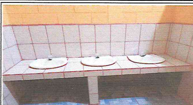
Foto 2: Instalacion de lavamanos y pintado.
