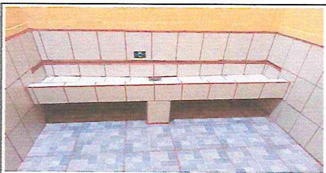
Foto 5: Remodelacion de mingitorio.
