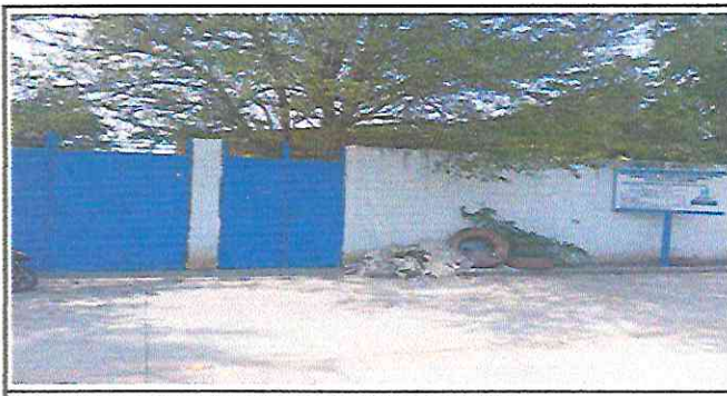
Foto 5: Preparacion de muro perimetral para pintura.
