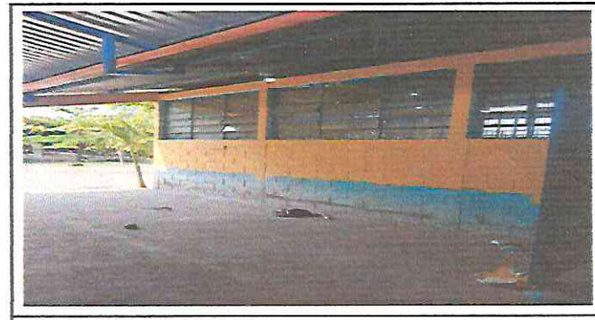
Foto 6: Inicio de pintado en aulas.
