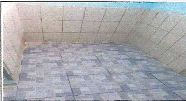
Foto 3: Intalacion de ceramico en piso de baños.
