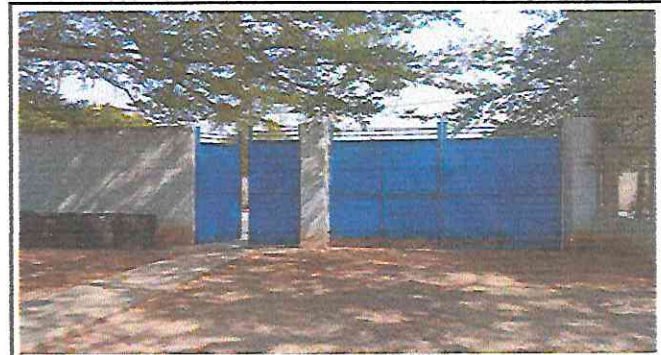
Foto 4: Preparacion de porton y puerta de ingreso para pintura.
