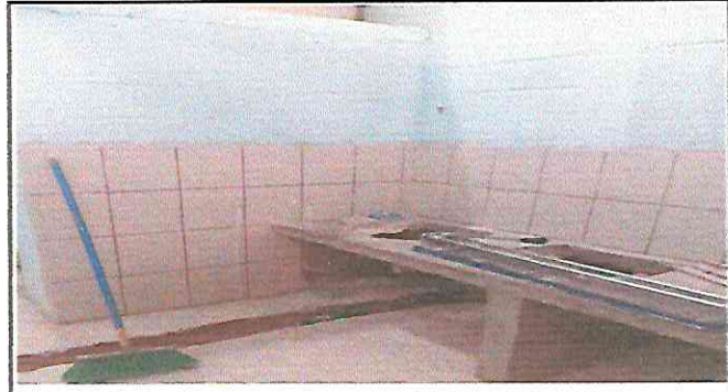
Foto 2: Sustitucion de lavamanos.
