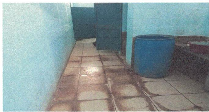
Se instalara piso ceramico debido al mal estado del existente
