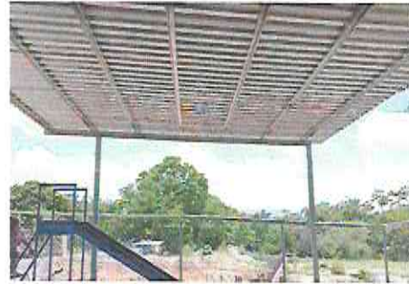
Foto 2: Instalación de lamina incluyendo estructura de soporte
