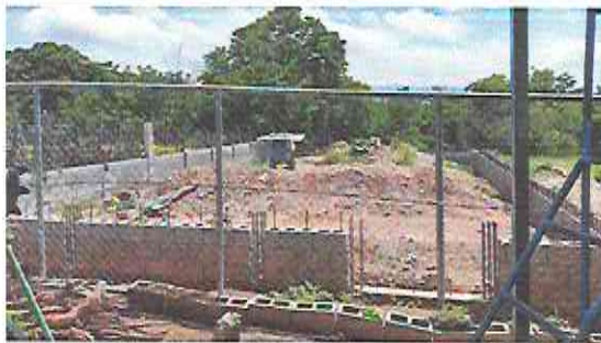
Foto 3: Reparación de tubo HG y malla metalica
