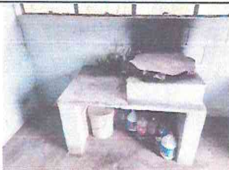
Foto 5: Sustitucion de estrufa rural.
