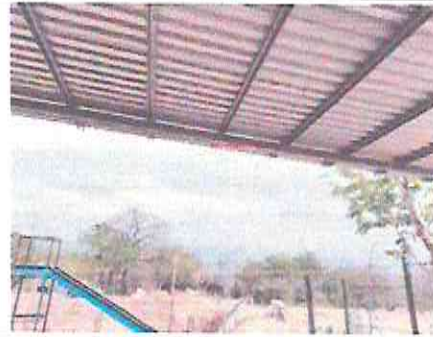
Foto 2: Instalacion de lamina incluyendo estructura de soporte.
