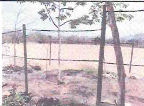
Foto 3: Reparacion de tubos HG y malla metalica.
