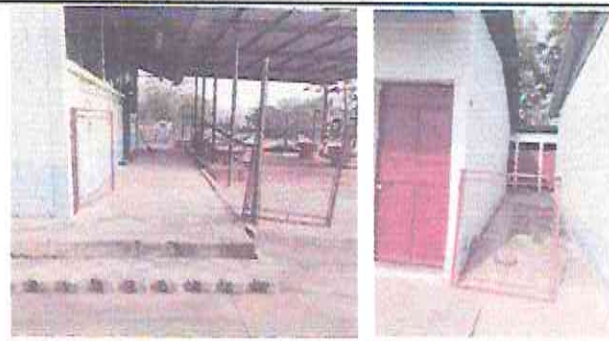
Foto 4: Cambio de porton de ingreso y puerta secundaria.
