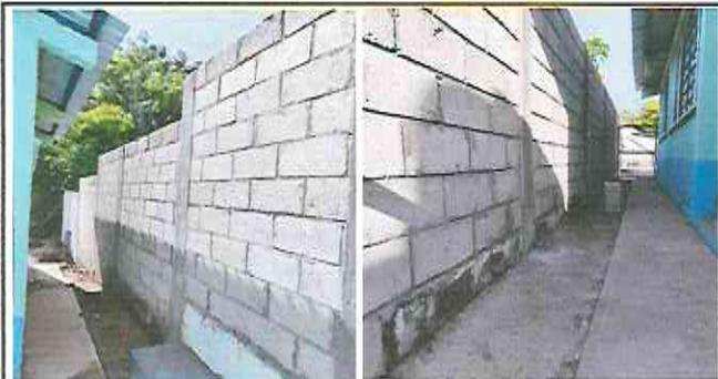
Foto 3: Sustitución de muro perimetral pro tipo block.
