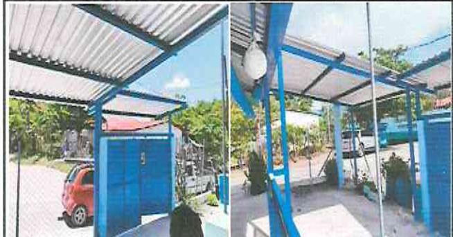
Foto 2: Instalación de techo de lamina troquelada, estructura de metal y columnas de metal.
