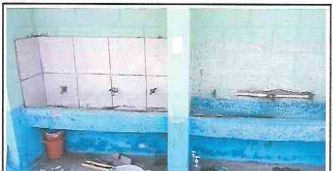
Foto 6: Instalación de azulejos en lavamanos.
