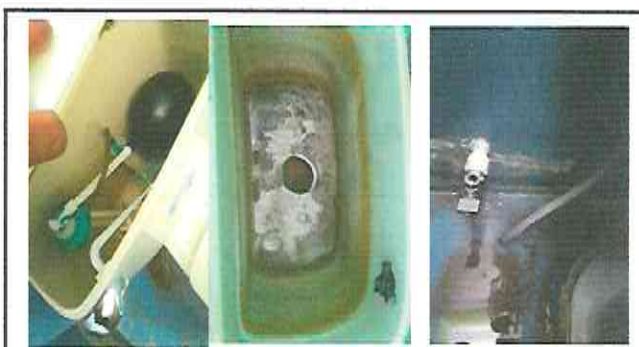
Foto 10: Sustitucion de accesorios en inodoro de baño.
