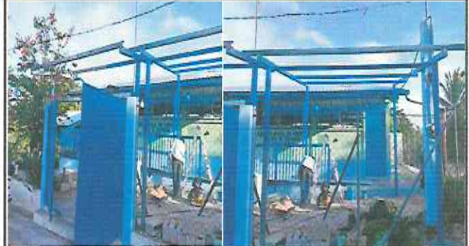
Foto 2: Instalación de estructura metálica y columnas de metal.
