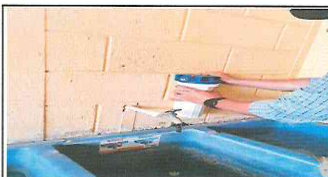
Foto 12: Instalacion de filtro para agua en cocina.
