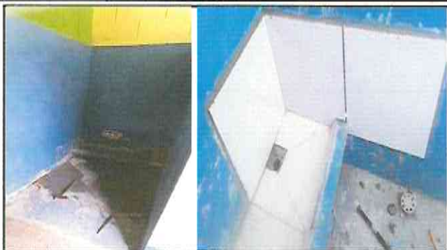
Foto 8: Instalacion de azulejo en urinal de baño.
