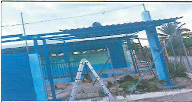
Foto 3: Instalación de lamina Troquelada.
