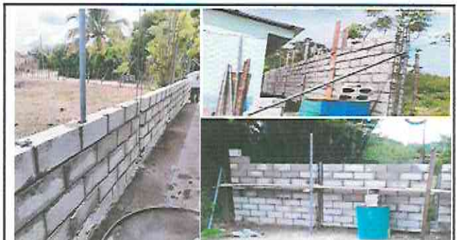
Foto 4: Sustitución de muro perimetral por tipo block.
