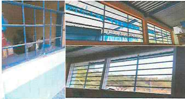
Foto 1: Instalación de ventanas de PVC.
