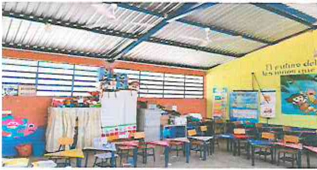
Foto 1: Cambio de ventanería de metal por ventanería de PVC en area de aula, cocina y bodega.
