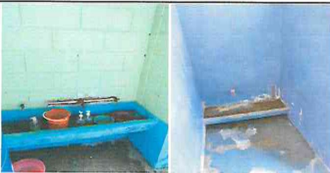
Foto 5: Colocacion de azulejo en area de lavamanos y urinal.
