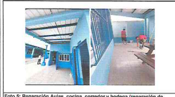
Foto 5: Reparación Aulas, cocina, corredor y bodega (reparación de rampa de acceso dañadas en puntos varios)
