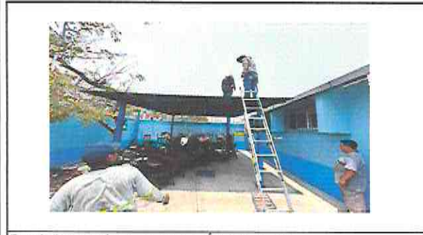
Foto 3: Reparación de cubierta de Área de Juegos.
