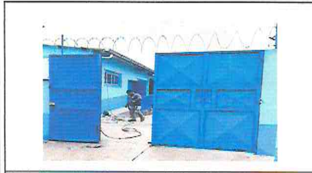
Foto 1: Reparación en Muro Perimetral. (Mantenimiento a Portón, Aplicación de pintura en interiores y exteriores; y Rotulo de la Escuela).
