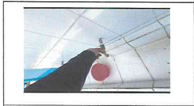
Foto 4: Reparación de Servicios Sanitarios. (Sustitución de artefactos, grifos o chorros).
