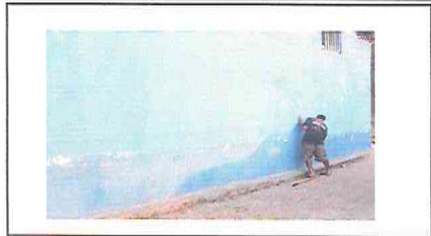
Foto 2: Reparación en Muro Perimetral. (Mantenimiento a Portón, Aplicación de pintura en interiores y exteriores; y Rotulo de la Escuela).
