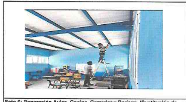
Foto 6: Reparación Aulas, Cocina, Corredor y Bodega. (Sustitución de focos ahorradores y Revisión de falla eléctrica).
