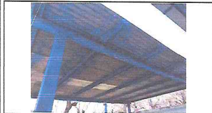
Foto 3: Reparación de Cubierta de Area de Juegos.
