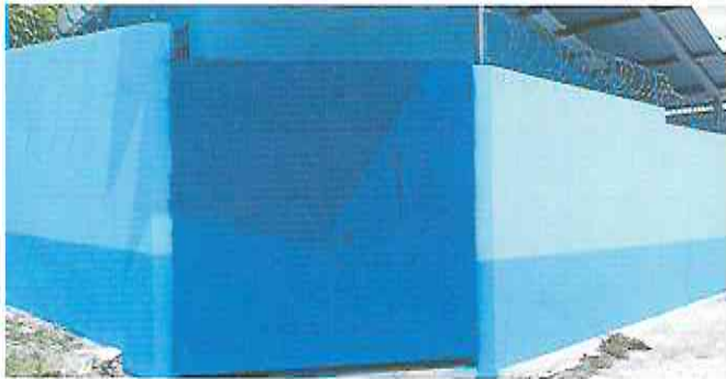
Foto 1: Mantenimiento preventivo porton de acceso.
