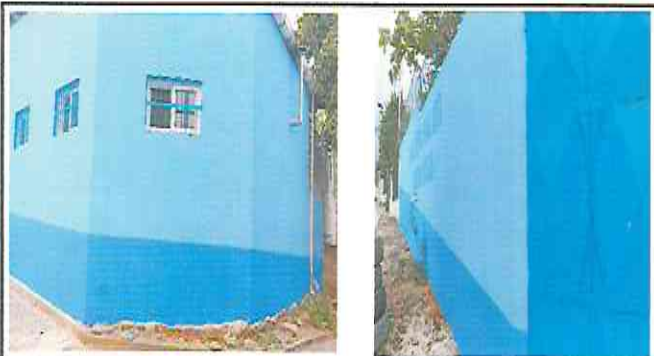
Foto 5: Pintura de muros exteriores e interiores.
