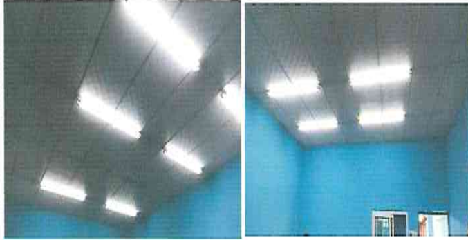
Foto 7: Reparación de cielo raso reticulado.
