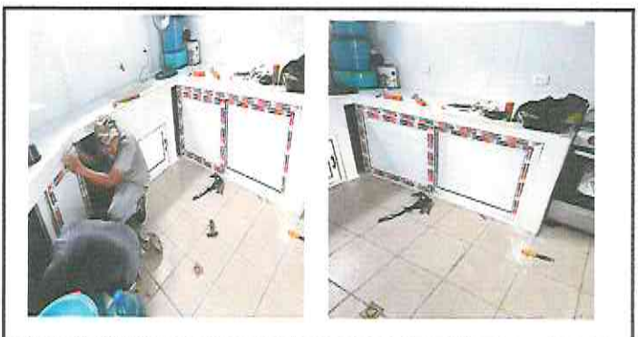
Foto 6: Sustitución o instalación de puertas para muebles de cocina.
