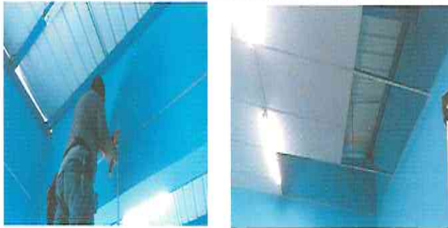
Foto 7: Reparación de cielo raso reticulado.
