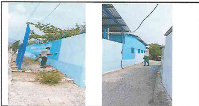
Foto 5: Pintura de muros exteriores e interiores.
