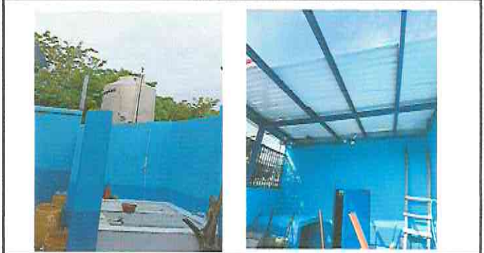
Foto 2: Sustitución o instalacion de lámina entre área de comedor y pasillo a la cocina, por lámina troquelada calibre 26.
