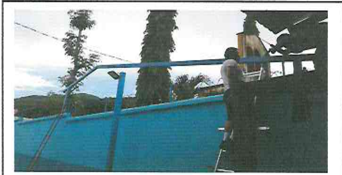
Foto 3: Sustitución o instalacion de lámina por lámina troquelada calibre 26.
