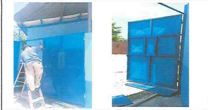
Foto1: Mantenimiento preventivo porton de acceso.
