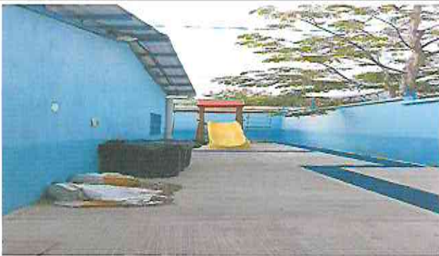
Foto 3: Sustitución o instalación de lámina por lámina troquelada calibre 26.
