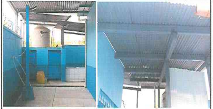
Foto 2: Sustitución o instalación de lámina entre área de comedor y pasillo a la cocina, por lámina troquelada calibre 26.
