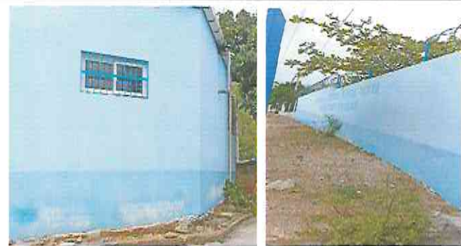
Foto 5: Pintura de muros exteriores e interiores.
