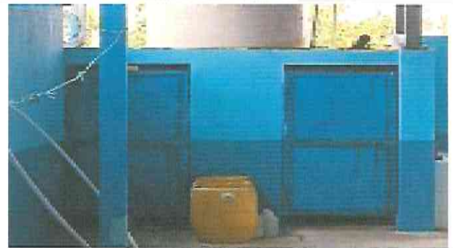
Foto 4: Mantenimiento de puertas de servicios sanitarios.
