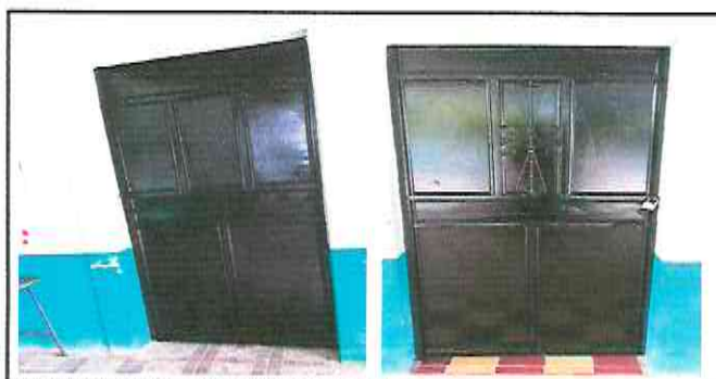
Foto 11: Mantenimiento a Puertas metalicas.
