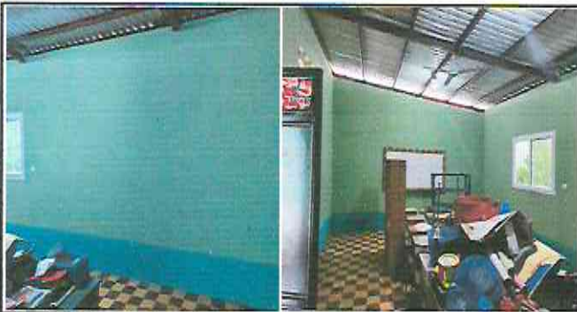
Foto 3: Aplicación de pintura en pared de aulas.
