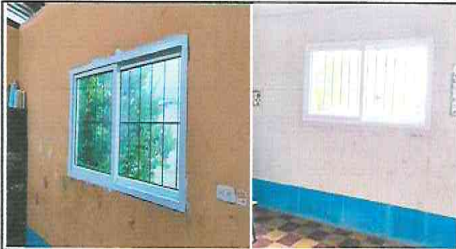
Foto 1: Instalación de ventanas de PVC en aulas.
