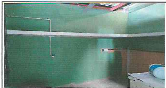
Foto 9: Aplicación de pintura en cocina.
