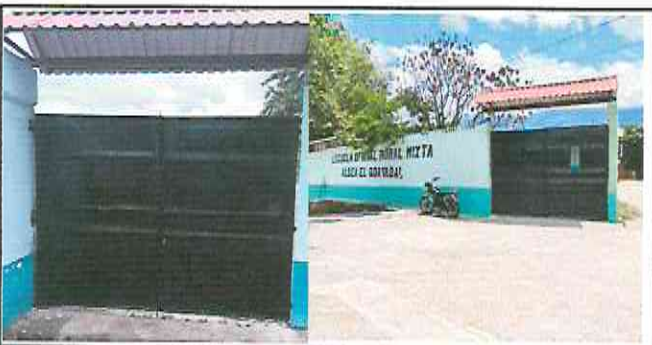
Foto 5: Sustitución e Instalación de porton Metalico de ingreso.
