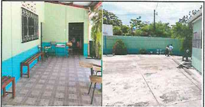
Foto 6: Aplicación de pintura en exteriores.
