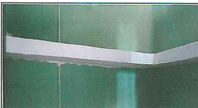
Foto 10: Instalacion de Repisa de concreto en cocina.
