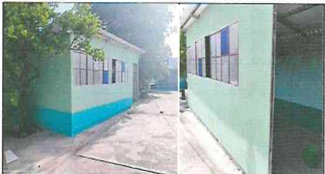
Foto 4: Instalación de Muros Divisorios para Aulas.
