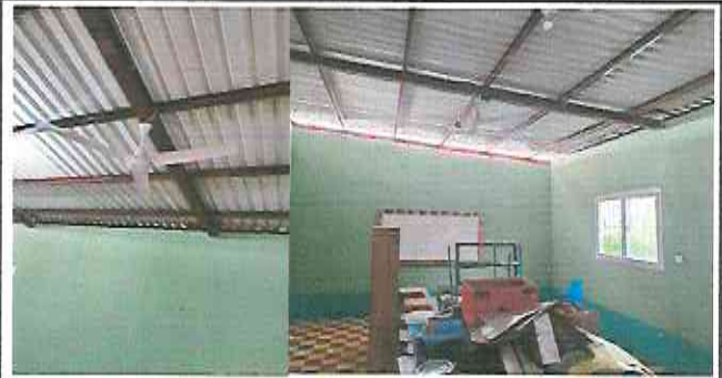
Foto 2: Cambio de Ventiladores en aulas.
