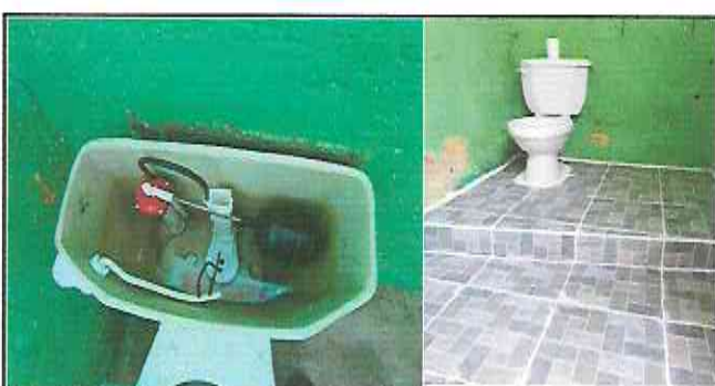
Foto 12: Sustitucion de accesorios en inodoros e Instalacion de piso en baños.
