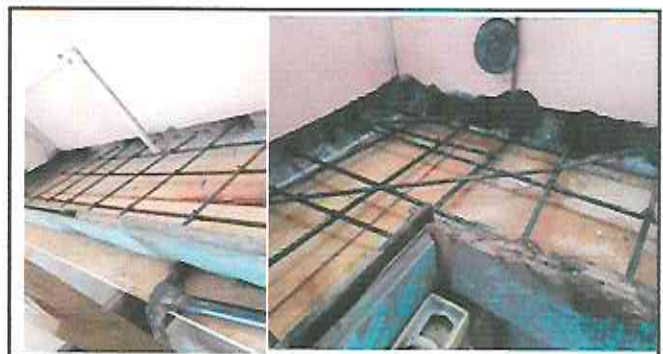
Foto 10: Instalación de Repisa de concreto en cocina.
