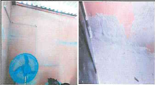
Foto 7: Reparación de Acabados en muros Cocina.
