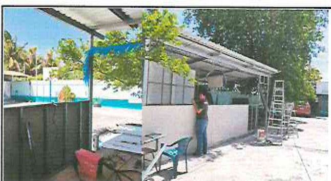
Foto 4: Instalación de Muros Divisorios para Aulas.
