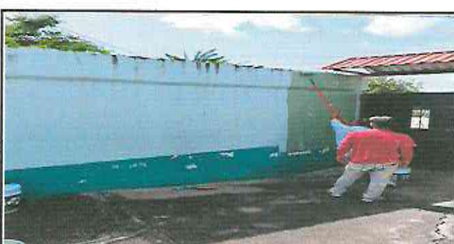
Foto 6: Aplicación de pintura en exteriores.
