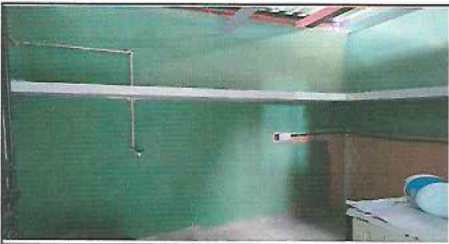
Foto 9: Aplicación de pintura en cocina.
