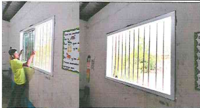
Foto 1: Instalación de ventanas de PVC en aulas.
