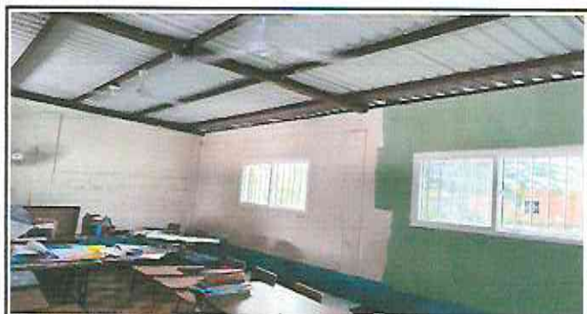
Foto 3: Aplicación de pintura en aulas.
