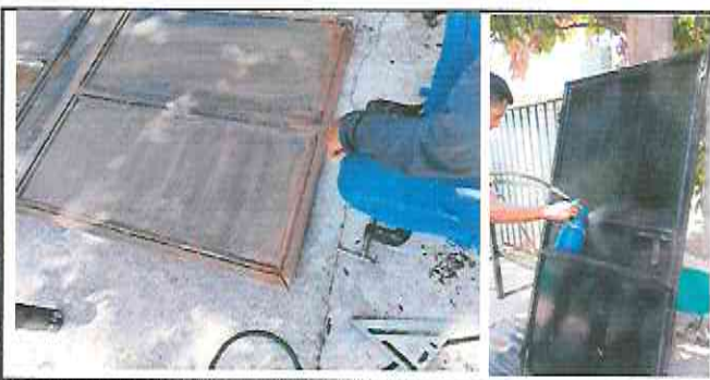
Foto 11: Mantenimiento a puertas metálicas.
