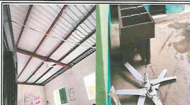
Foto 2: Cambio de Ventiladores en aulas.
