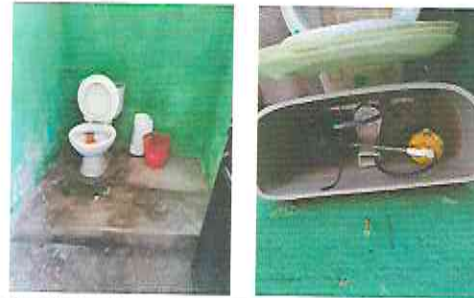
Foto 4: Sustitución de accesorios de inodoros en baños.
