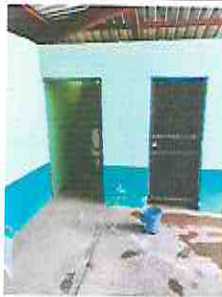
Foto 3: Mantenimiento a puertas en baños, cocina y aulas.
