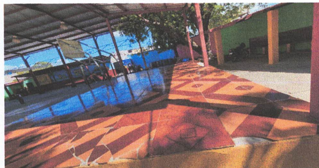
Foto 8: Se sustituirá el piso de cerámico y se instalará piso cerámico en el escenario
