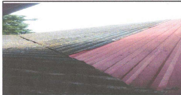
Foto 4: SUSTITUCIÓN DE LAMINA DE DURALITA POR LAMINA TROQUELADA ALUZINC SECADA AL HORNO COLOR ROJO CALBRE 26 EN AULAS
