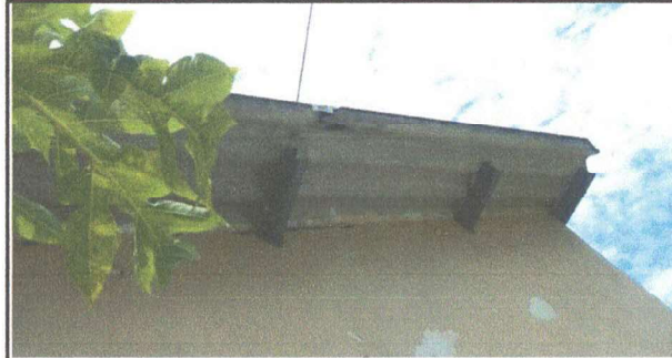
Foto 2: SUSTITUCIÓN DE LAMINA DE DURALITA POR LAMINA TROQUELADA ALUZINC SECADA AL HORNO COLOR ROJO CALBRE 26 EN AULAS
