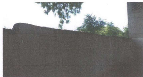
Foto 6: INSTALACIÓN DE RAZOR RIBBON EN MURO PERIMETRAL
