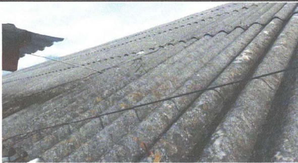
Foto1: SUSTITUCIÓN DE LAMINA DE DURALITA POR LAMINA TROQUELADA ALUZINC SECADA AL HORNO COLOR ROJO CALBRE 26 EN AULAS
