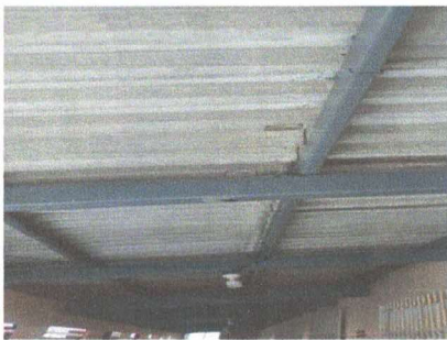
Foto 3: SUSTITUCIÓN DE LAMINA DE DURALITA POR LAMINA TROQUELADA ALUZINC SECADA AL HORNO COLOR ROJO CALBRE 26 EN CORREDOR
