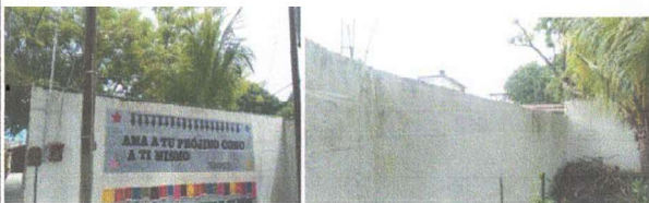
Foto 5: INSTALACIÓN DE RAZOR RIBBON EN MURO PERIMETRAL
