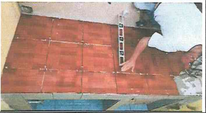
Foto 3: Instalación de azulejo en la parte de arriba de la pila.
