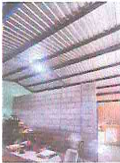
Foto 5: INSTALACION DE LAMINA, POR LAMINA TROQUELADA ALUZING CALIBRE 26 EN MODULO DE AULAS
