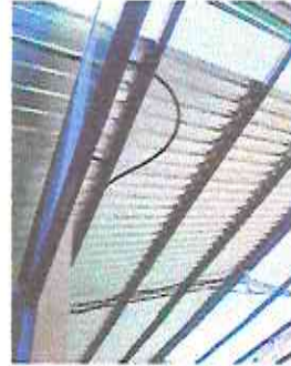
Foto 2: SUSTITUCION DE LAMINA, POR LAMINA TROQUELADA ALUZINC CALIBRE 26 EN MODULO DE AULAS
