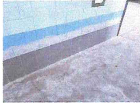
Foto 2: COLOCACION DE DE PISO CERAMICO EN MODULO DE AULAS
