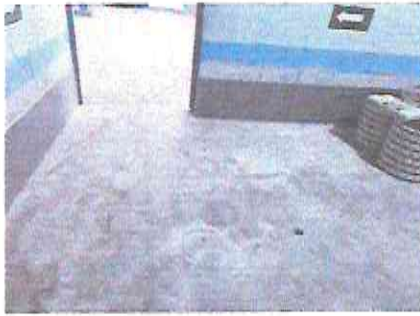
Foto1: COLOCACION DE DE PISO CERAMICO EN MODULO DE AULAS
