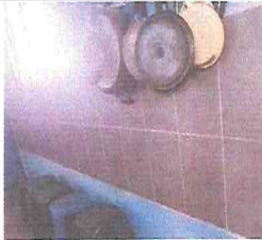
Foto 3: COLOCACION DE PISO CERAMICO EN MODULO DE COCINA
