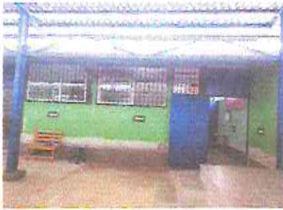
Foto 1: SUSTITUCION DE PISO CERAMICO EN MODULO DE AULAS
