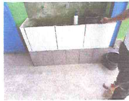
Foto 4: COLOCACION DE PISO CERAMICO EN AREA DE MODULO DE BAÑO
