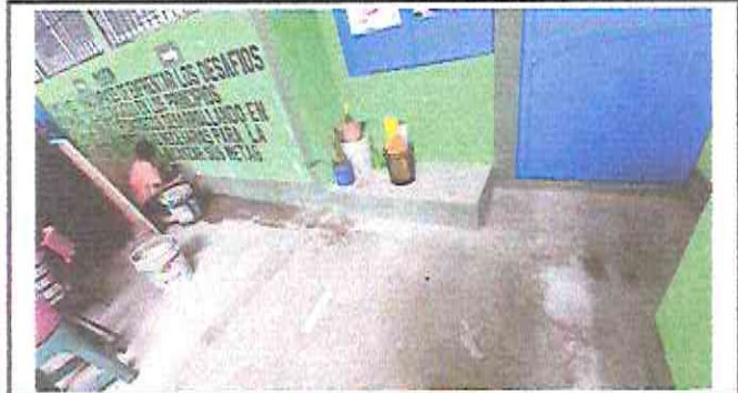
Foto 1: MANTENIMIENTO DE ZOCALO INFECTADO MAS RESANADO Y COLOCACION DE ZOCALO DE CERAMICO
