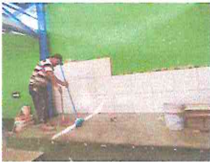
Foto 3: COLOCACION DE PISO CERAMICO EN MODULO DE ESCENARIO
