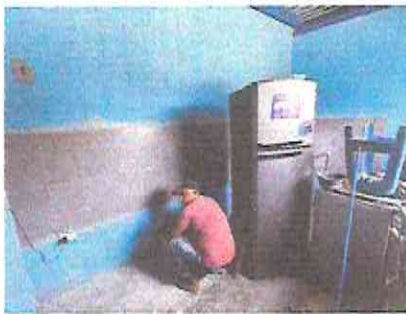
Foto 3: COLOCACION DE PISO CERAMICO EN MODULO DE COCINA
