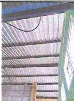
Foto 5: SUSTITUCION E INSTALACION DE LAMINA, POR LAMINA TROQUELADA ALUZINC CALIBRE 26 EN MODULO DE AULAS
