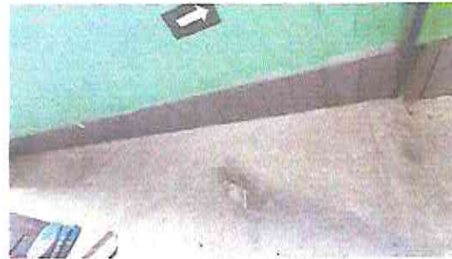
Foto 2: COLOCACION DE PISO CERAMICO COMO ZOCALO EN AULAS
