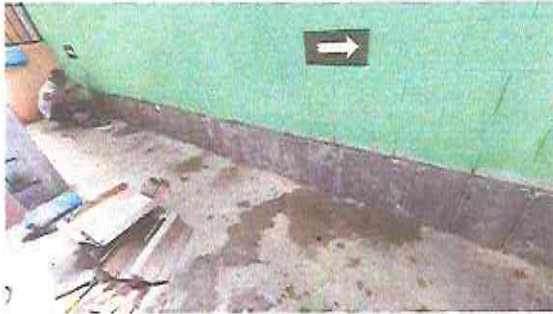
Foto1: COLOCACION DE PISO CERAMICO COMO ZOCALO EN AULAS
