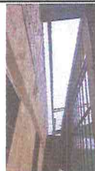
FOTO 6: INSTALACION DE CANAL DE METAL EN MODULO DE AULAS
