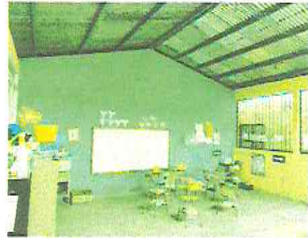
Foto 2: Demolicion de muro para ampliacion de aula.
