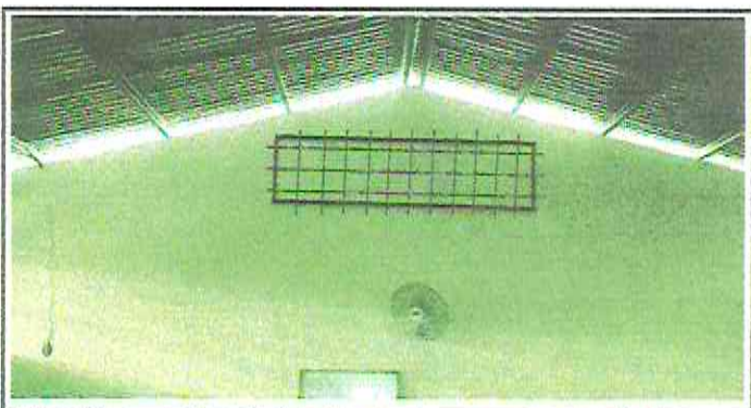
Fotografía: suministro e instalacion de rejas para vano en mojinete
