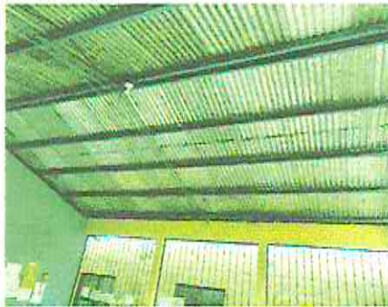
Foto 1: Desmontaje y cambio de lamina existente con canal metalico
