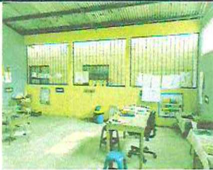
Foto 3: Area de muros divisorios para aula.
