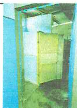
Foto 6: Cambio de puertas de madera a PVC en baños.
