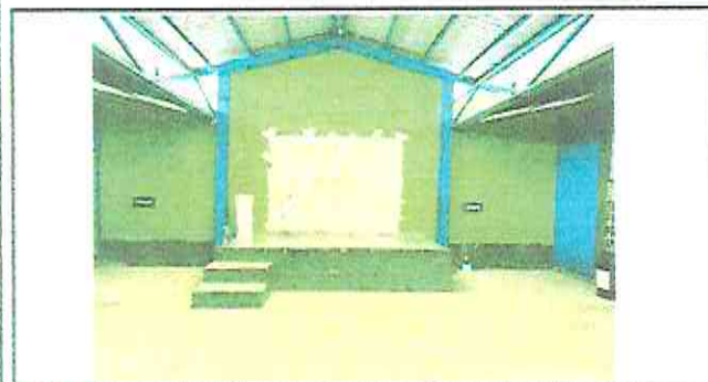
FOTOGRAFIA: SUSTITUCION DE PISO CERAMICO EN MODULO DE ESCENARIO
