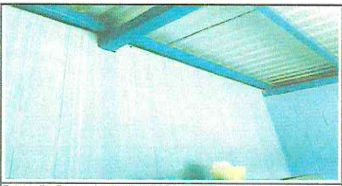
Fotografía: Reparacion de filtracion entre lamina y pared
