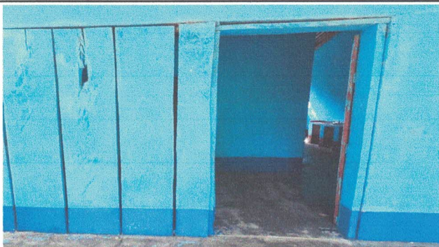
Foto 3: Fabricación e Instalación de porton
