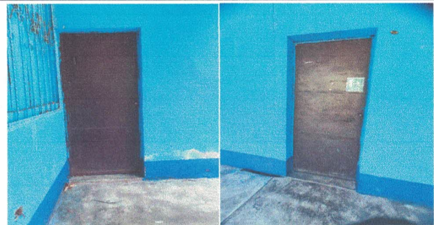
Foto 6: Cambio de chapas
