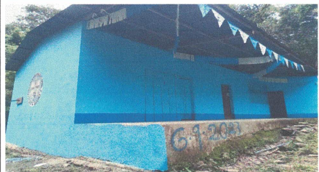
Foto 2: Sustitución de lámina en la parte frontal
