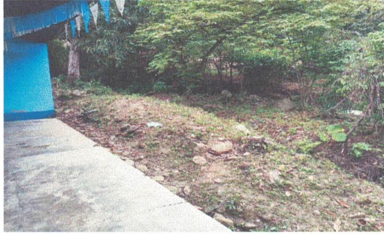
Foto 1: Reparación Muro de Contención
