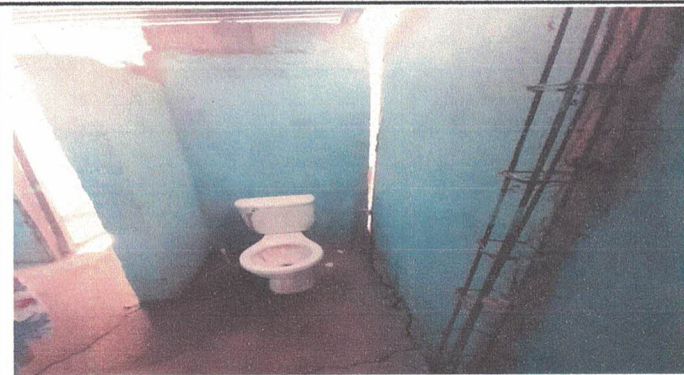
Instalacion de inodoros y suministros
