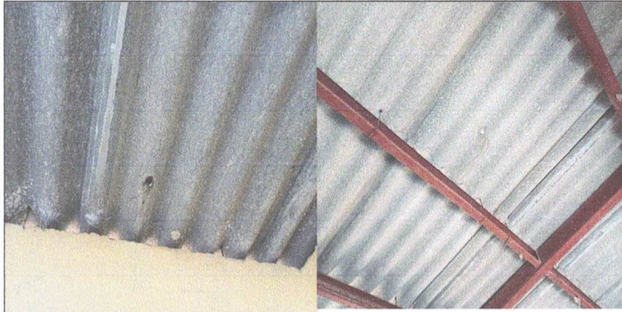
SUSTITUCION DE LAMINA POR LAMINA TROQUELADA ALUZINC Y SUSTITUCION DE CAPOTES DE LAMINA PARA LAMINA TROQUELADA
